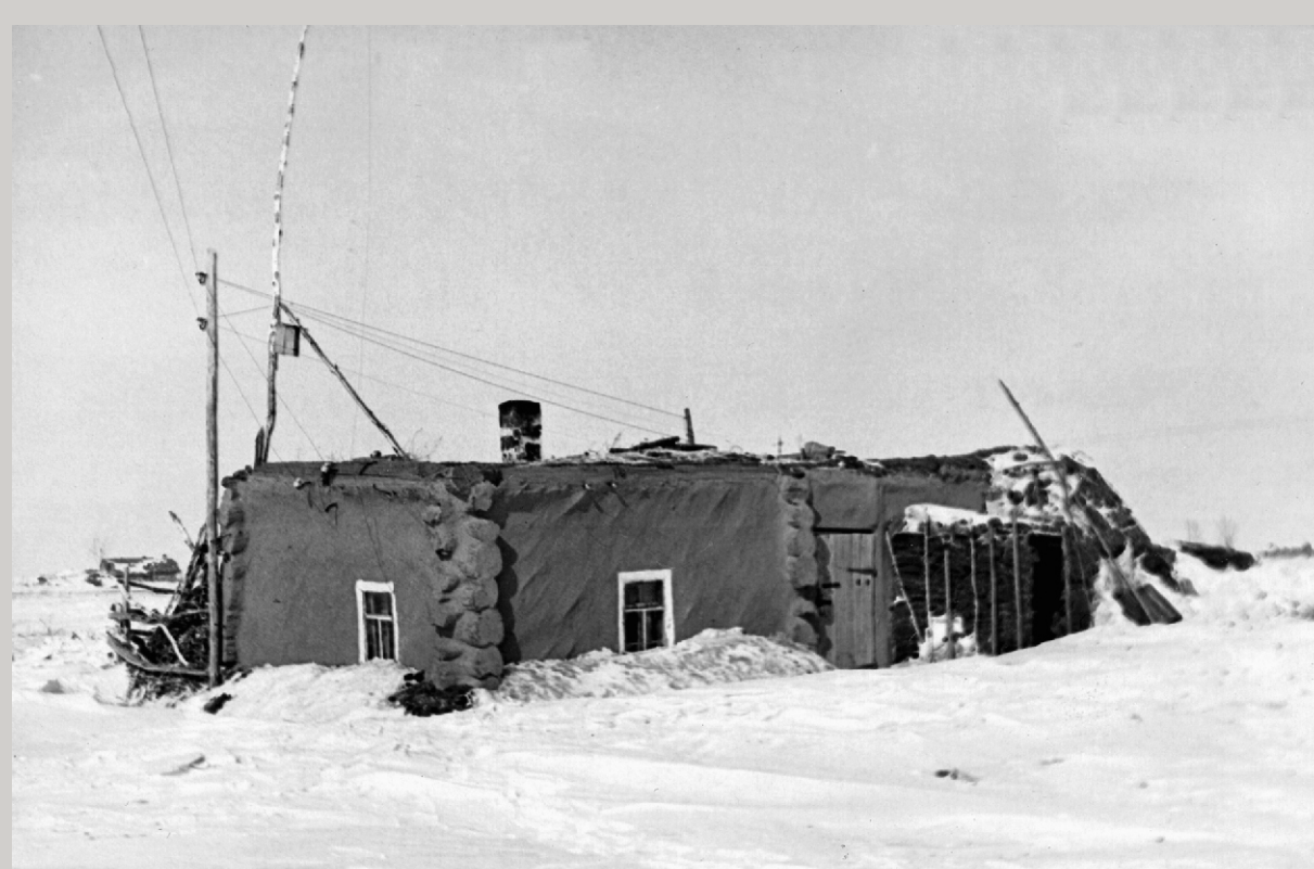
Küüditatute elamu Novosibirski obl Kotški raj Böstruhha külas (1949). Elamus on üks tuba suure vene ahjuga. Maja on puidust, väljast plätserdatud kohaliku saviga, katuseks mullamättad. Majaga külgneb okstest punutud ja saviga plätserdatud loomalaud [R 4]
